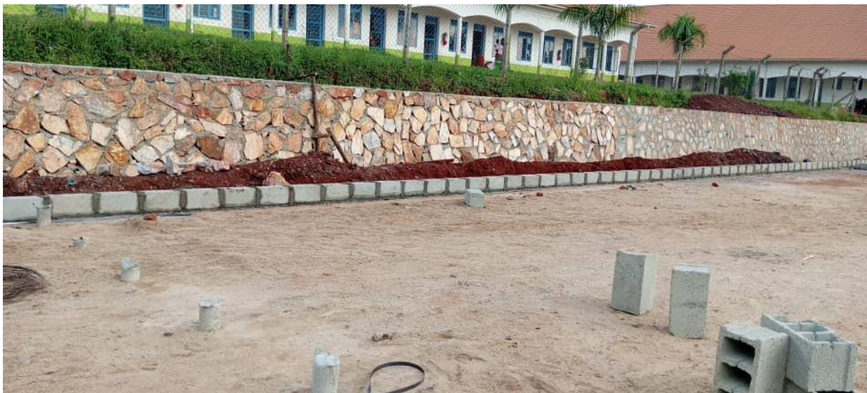
November: 50 meter lange supportmuur en bouw buitenmuren begint
