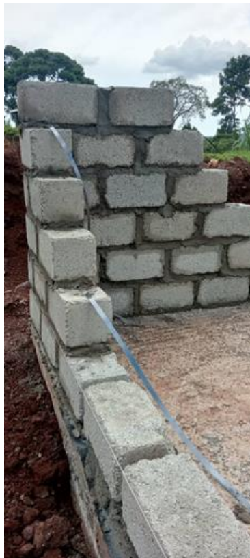
De dragende muren worden gebouwd met CBS blokken
