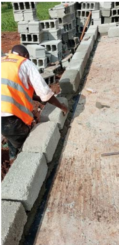
De dragende muren worden gebouwd met CBS blokken
