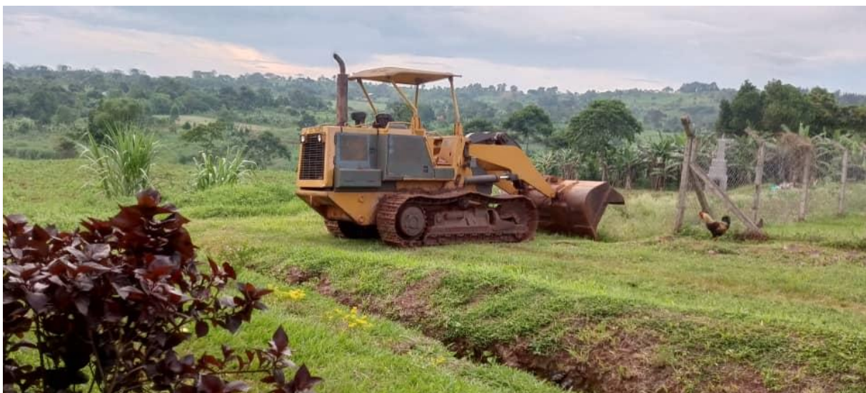
Begin egalisering en afgraving naar solide grond voor de fundering
