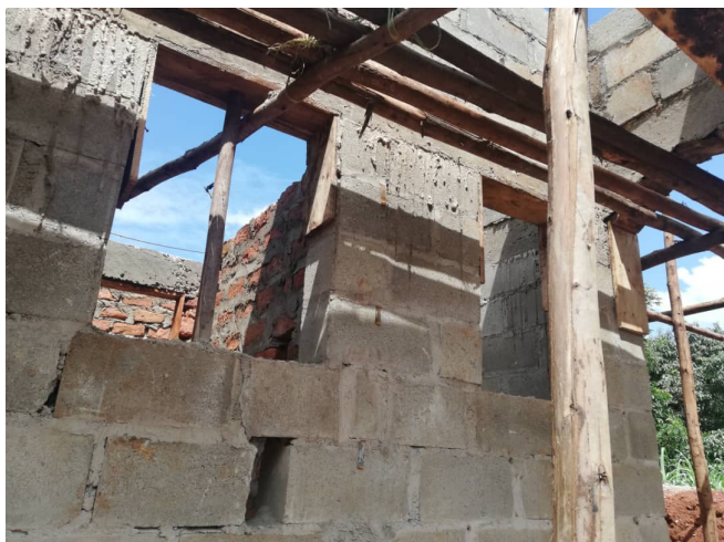
11. Muren in de steigers
