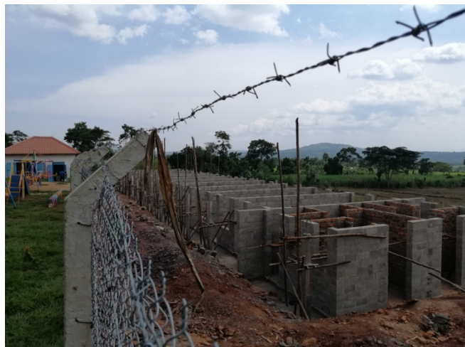
10. Muren VT Centrum
