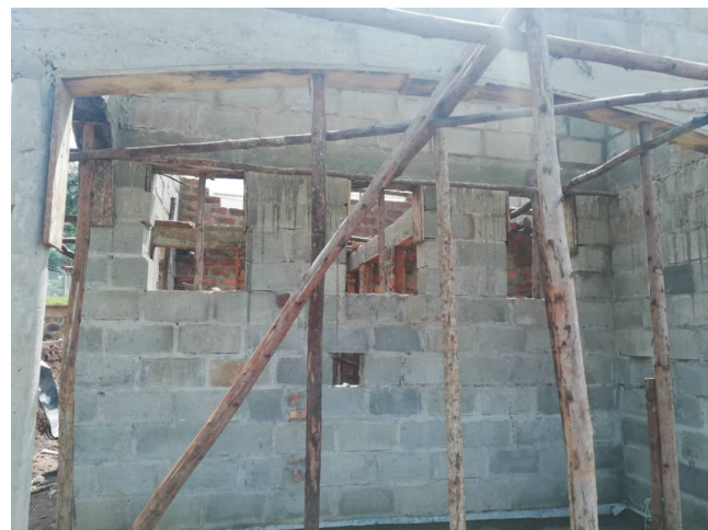
12. Toiletten in aanbouw
