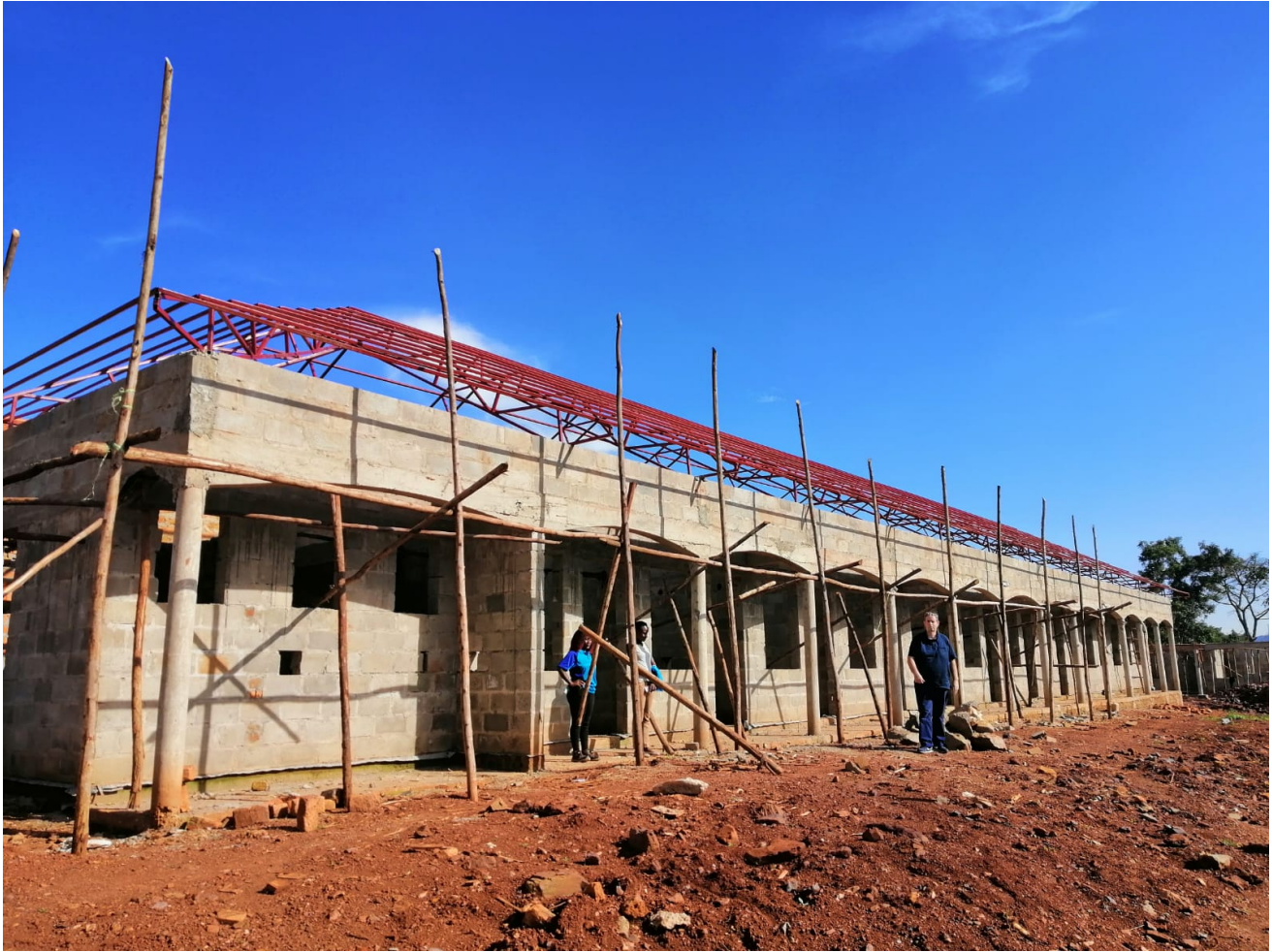
14. Het dak in aanbouw en SP-voorzitter Arie inspecteert in november
