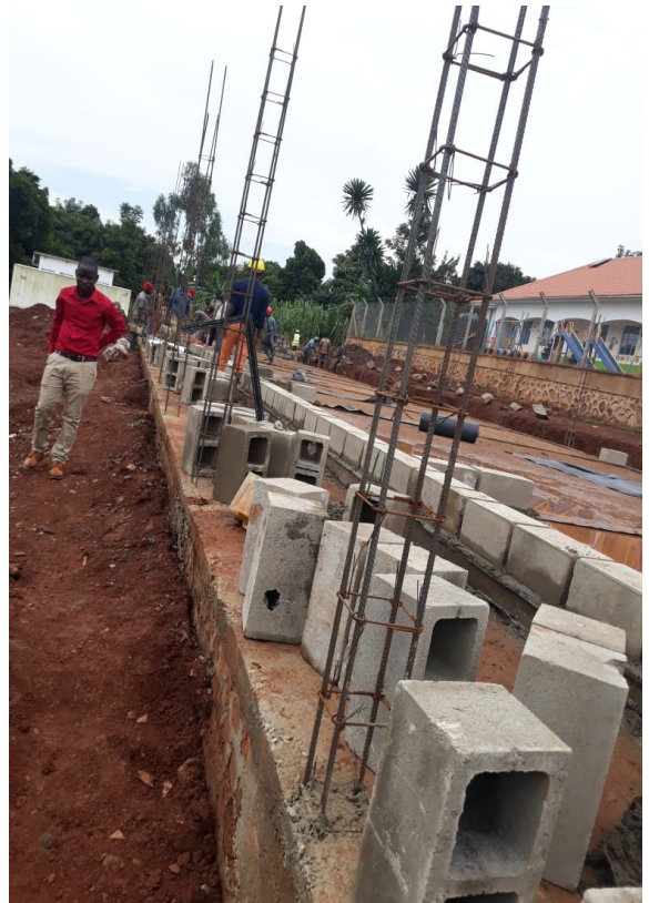
8. Fundering afgerond en start muren
